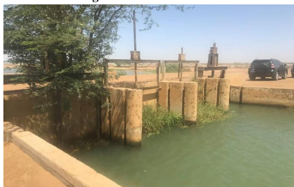
Photo 1 : Ouvrage de Ross Béthio à réhabiliter
