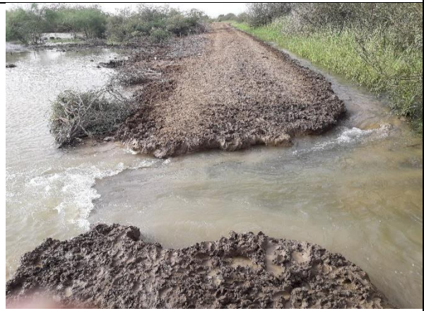
Photo 11 : Point de rupture sur la digue_RD
