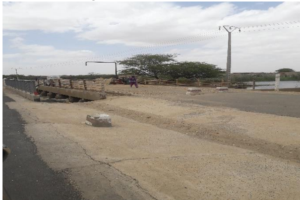
Photo 5 : Ouvrage de Ndiawdoune à démolir
