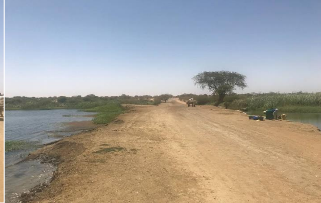
Photo 4 : Piste traversant l'ouvrage de Ndiol
