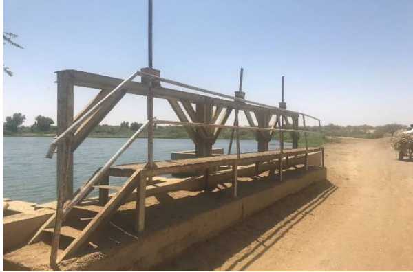
Photo 3 : Ouvrage de Ndiol à réhabiliter
