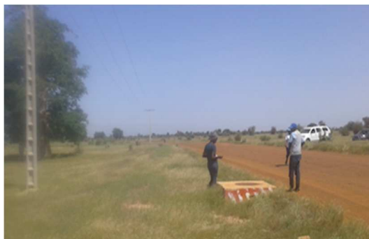
Photo 12 : route et ligne MT et réseau SDE dans l'emprise de la conduite secondaire
