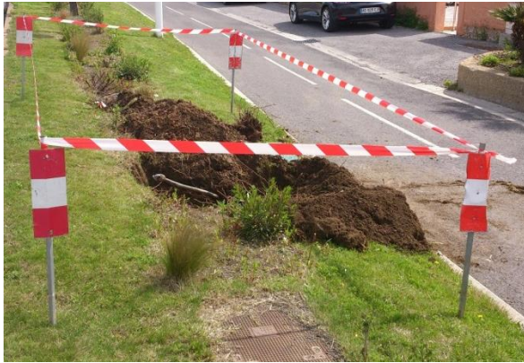
Photo 20 : Balisage des fouilles
