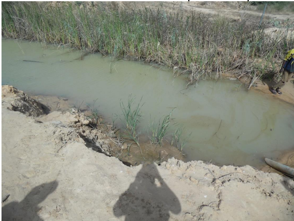
Photo 16 : Seuil non conforme utilisé dans le périmètre en exploitation
